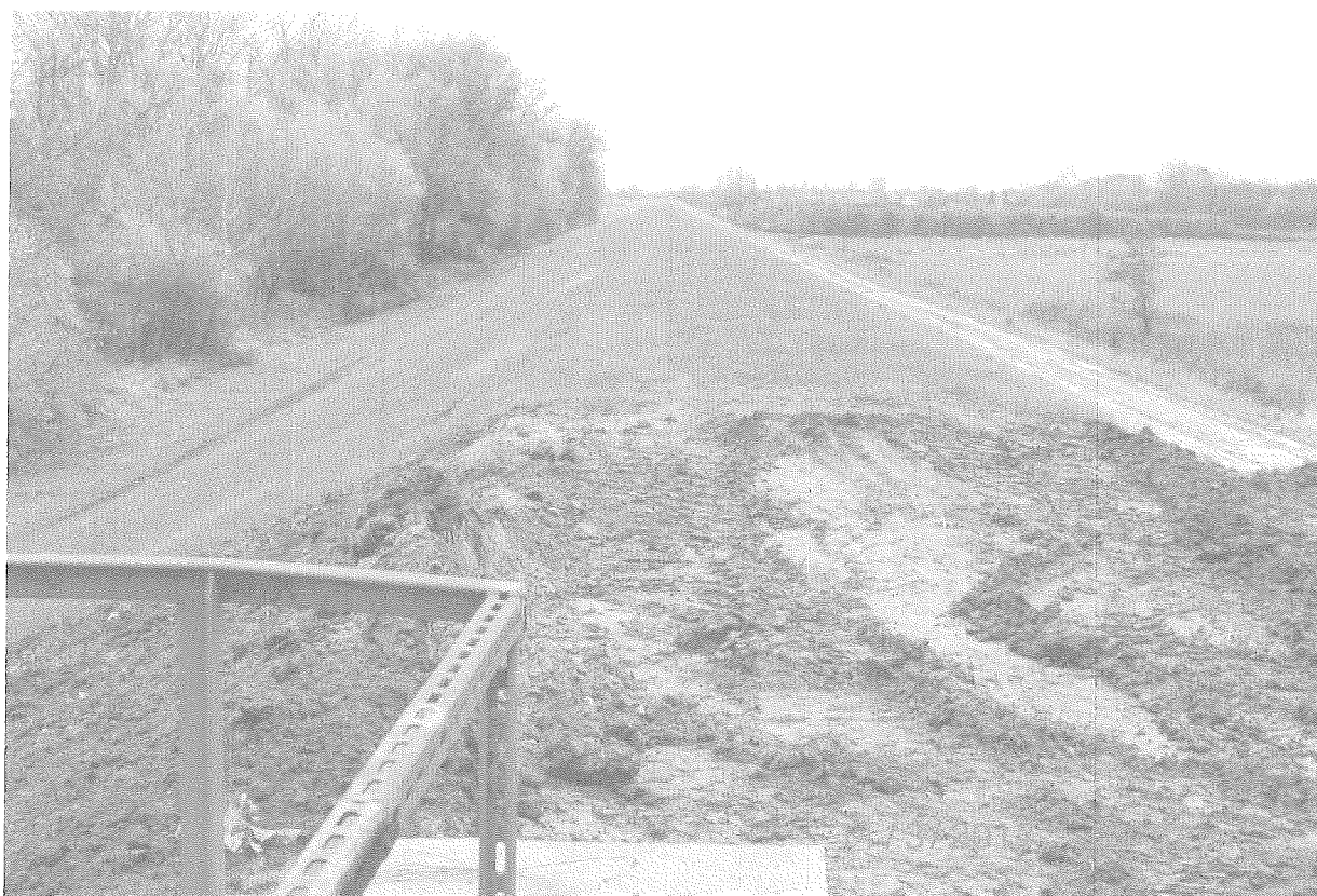
Fot. Zmodernizowany odcinek wału w km 9+300-9+589
